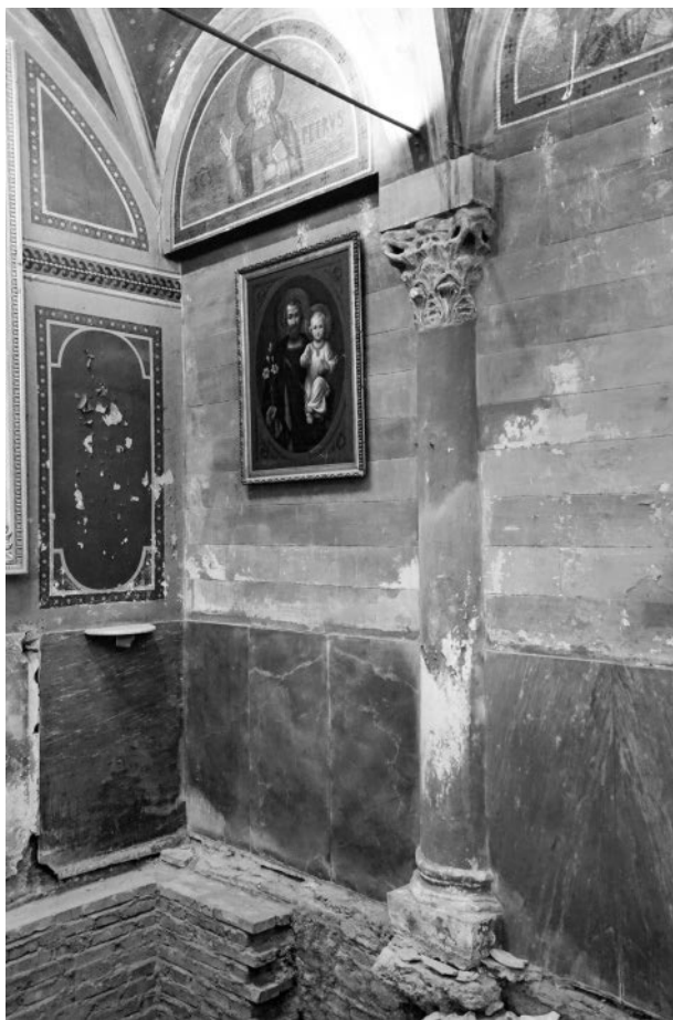
Abb. 95: Rom, S. Maria in Cappella, östlicher Abschnitt der südlichen Seitenschiffswand mit eingeschlossener Säule (Foto Claussen 2017)
