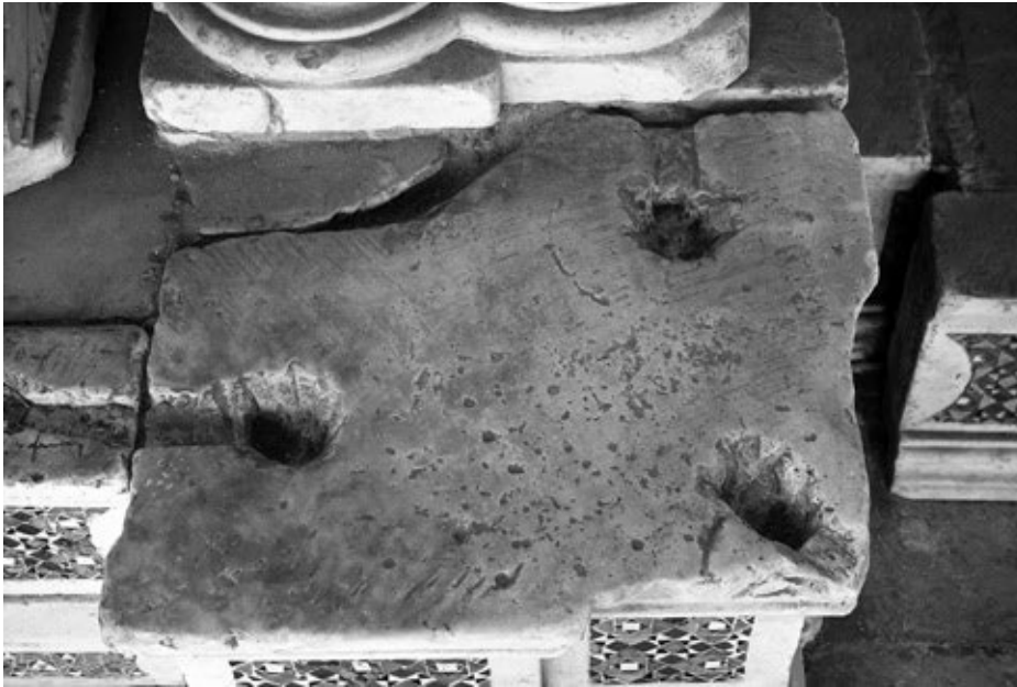
119. Rom, S. Giovanni in Laterano, Spuren der Eisenklammern der rechten Ecke des oberen Tabernakelabschlusses. (Foto Senekovic)
