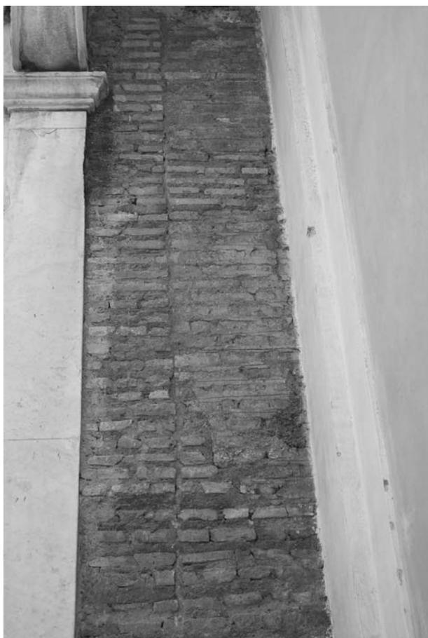
Abb. 23: Rom, S. Maria in Aracoeli, Mauerwerk des 12. Jhs. mit Falsa cortina und Stilatura, rechts des südlichen Eingangs unter dem ehemaligen Glockenturm (Foto Mondini 2003)
