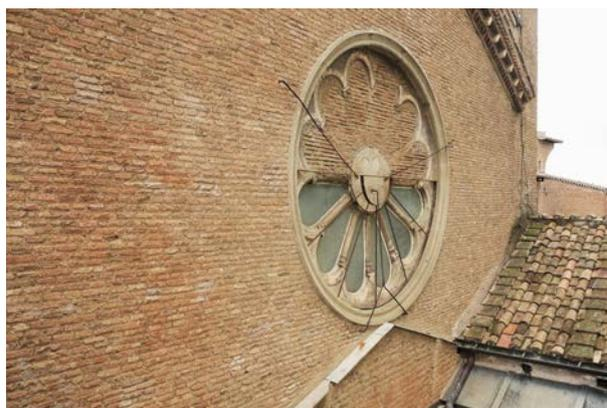
Abb. 28: Rom, S. Maria in Aracoeli, Nordquerhausfront mit Rose, darunter eingebaute Tuffellimauer eines älteren angebauten Gebäudes mit Satteldach (Foto Mondini 2023)
