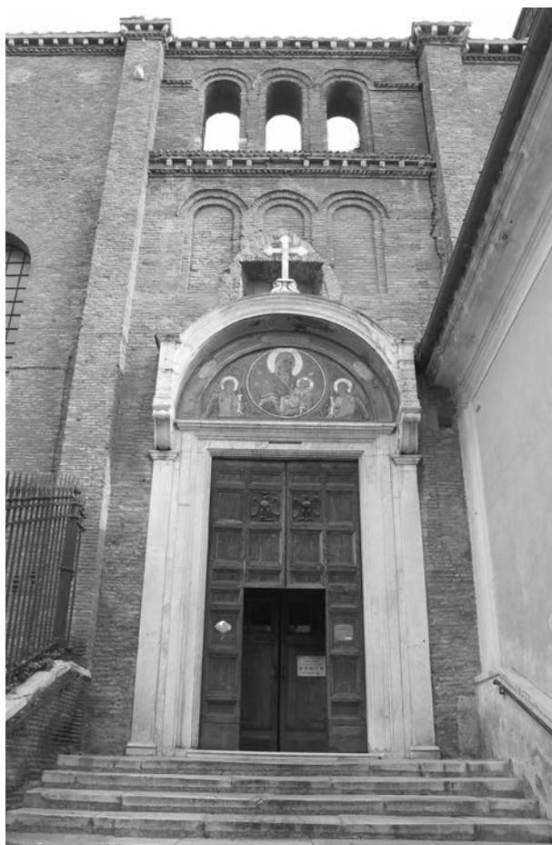
Abb. 5: Rom, S. Maria in Aracoeli, Reste des Glockenturms des 12. Jhs. mit nachträglich eingebrochenem Südeingang, Mauerwerkresten in Falsa cortina des 12. Jhs. und Baufuge zum Querhaus (Foto Mondini 2009)
