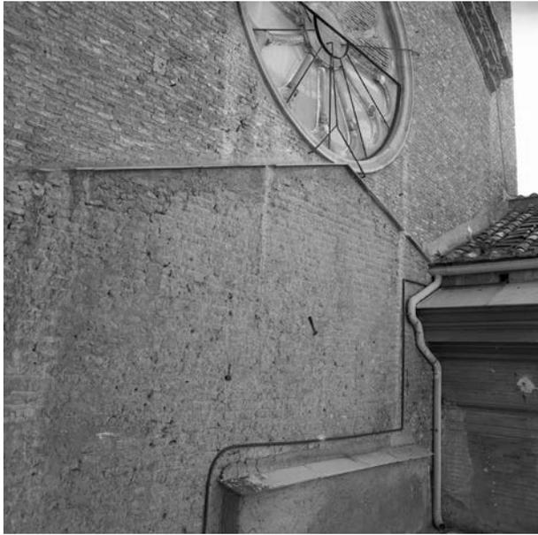
Abb. 27: Rom, S. Maria in Aracoeli, Nordquerhausfront mit eingebauter Tuffelli-Mauer eines älteren angebauten Gebäudes mit Satteldach (BHR Fotothek, Archivio Cesare D'Onofrio)
