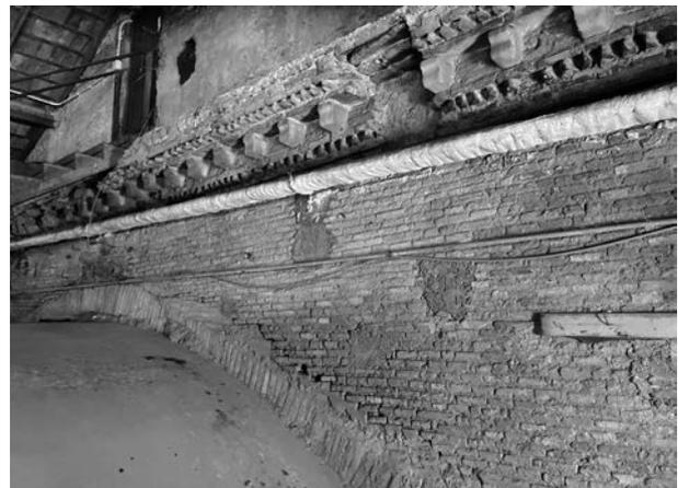
Abb. 18: Rom, S. Maria in Aracoeli, Bogen der gotischen Apsis und Reste eines Konsolgesimses, aufgenommen vom Dachstuhl des Chors aus (Mondini 2023)
