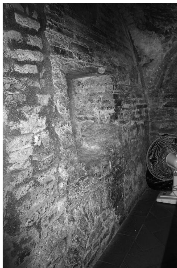
fig. 353: Roma, S. Maria in Tempulo, interno del campanile, con la ghiera della nicchia in basso a sinistra, sotto la finestrella quadrata, e l'imposta della volta in muratura, in alto a destra (foto Pollio 2017)
