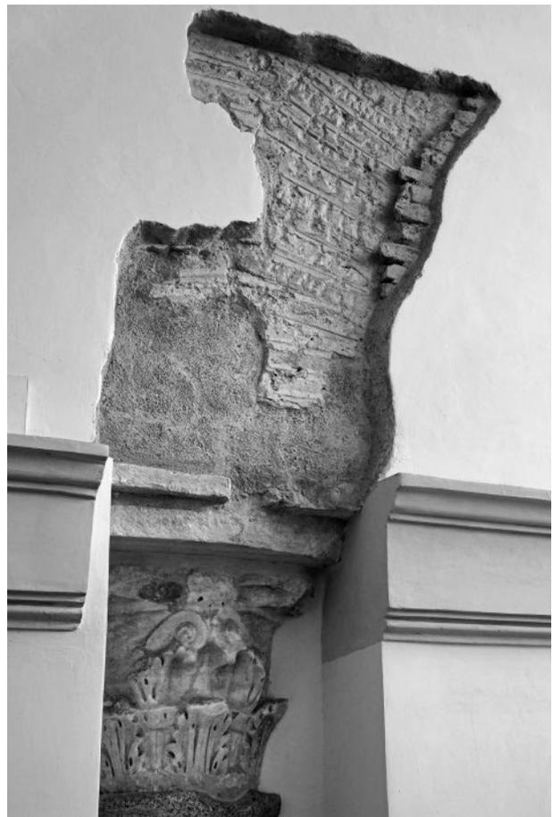
Abb. 432: Rom, SS. Michele e Magno, Kämpferzone und Arkadenansatz über der freigelegten Langhaussäule (Foto Claussen 2017)
