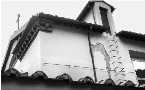
Abb. 413: Rom, SS. Michele e Magno, südliche Fassadenecke mit alter Fensterarkade und Traufgesims (Foto Claussen 2012)
